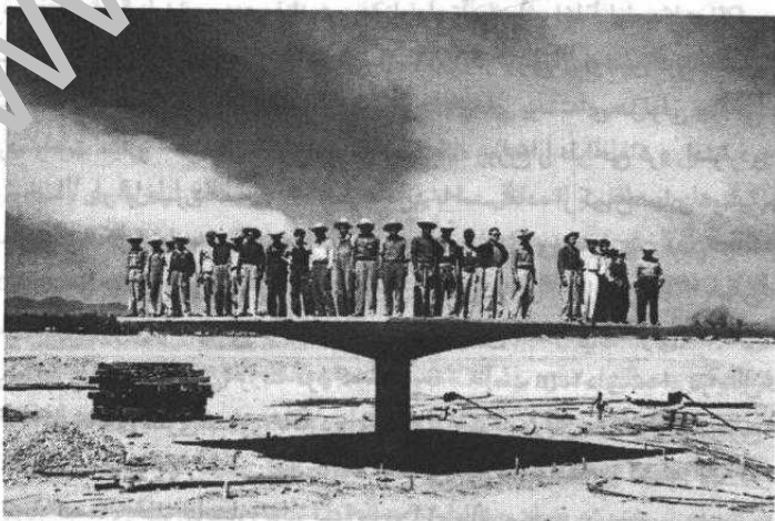
هذلولی به‌شکل چتر در جریان آزمایش یک سازه‌ی باربر، وایخو، مکزیکوسیتی، ۱۹۵۳
