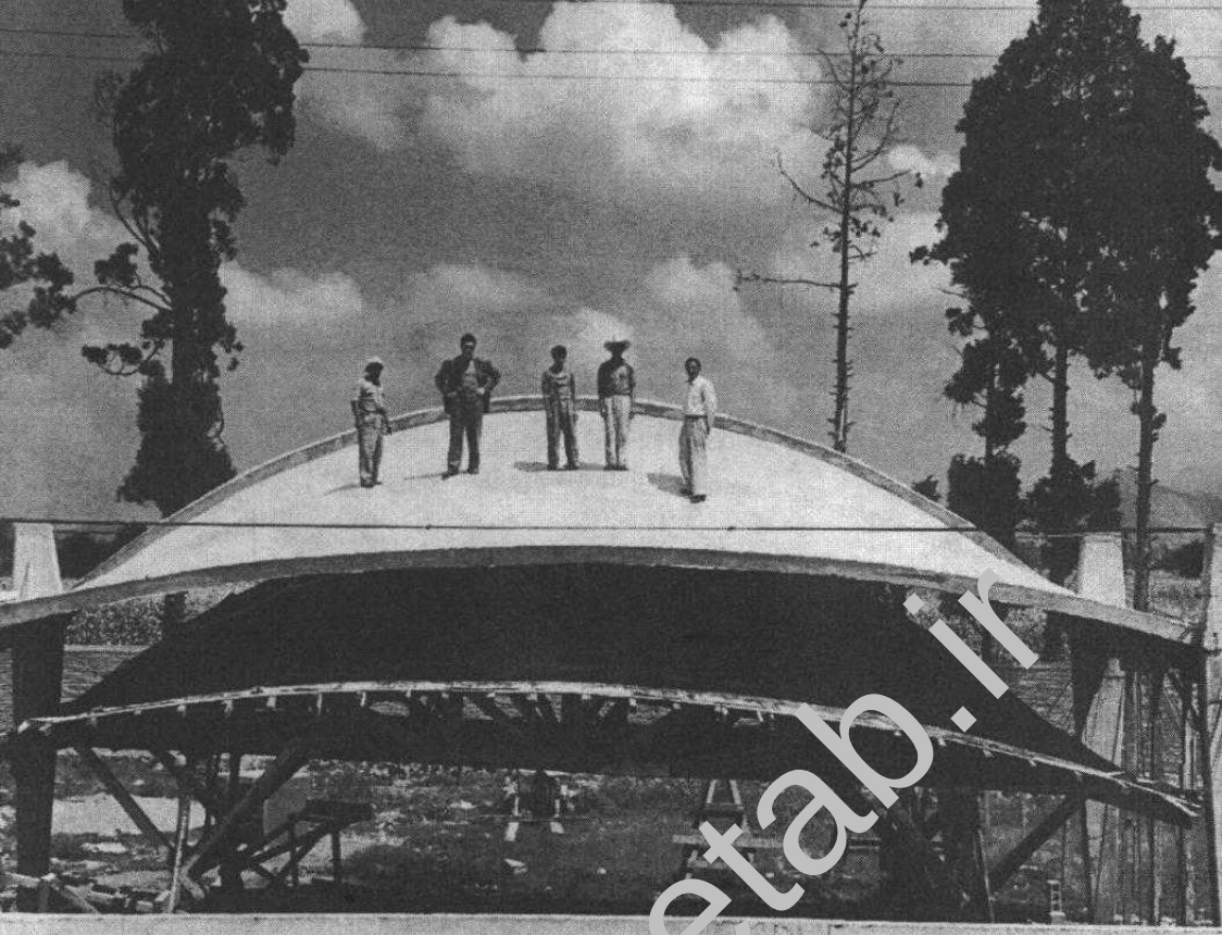
بام پوسته‌ای آزمایشی برای کارخانه‌ی راثول فرناندز، سن بارتولو، مکزیک، ۱۹۵۰
